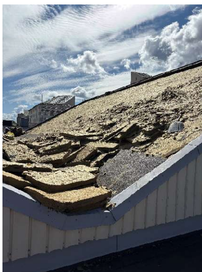
Start rivning av isolering på lanternin
