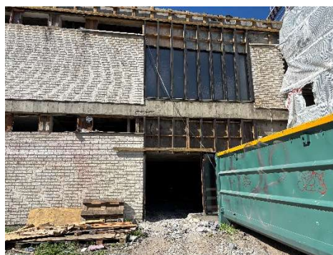
Uttransportsväg för rivningsmassor hus 5 (närmast Tunnelbanestationen)
