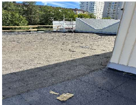
Rivning av tätskikt på tak
