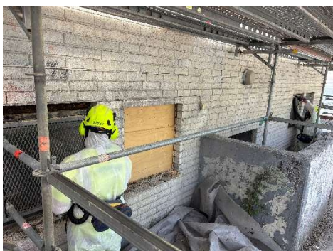
Sanering runt befintligt fönsterparti
